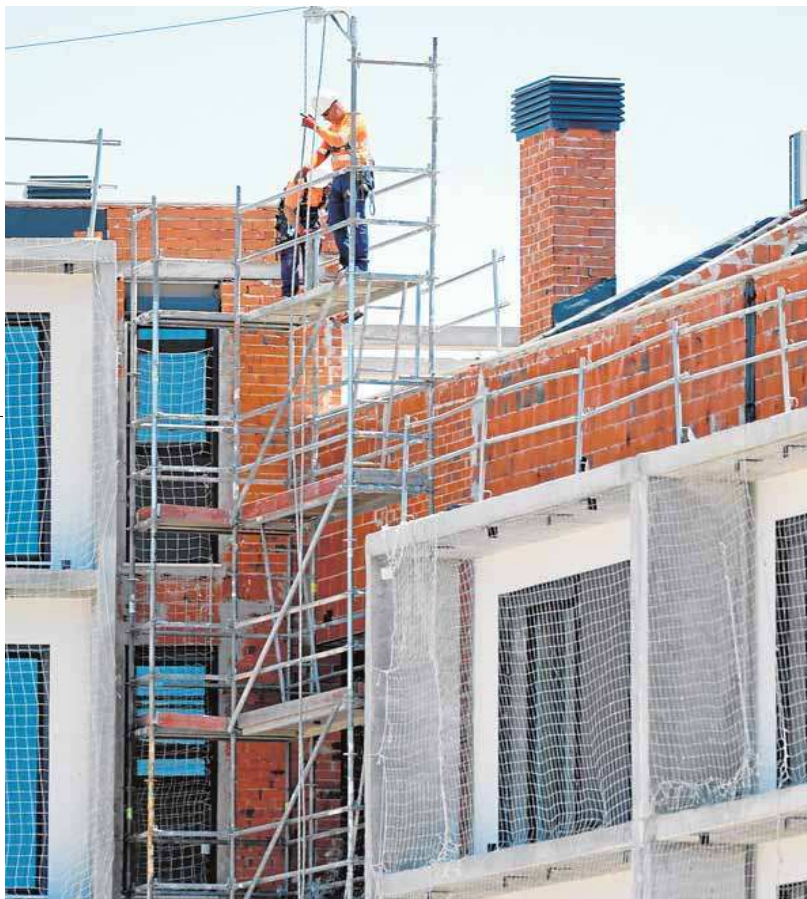
Operarios trabajando en una promoción de viviendas en la urbanización Montevida, en Murcia. EDU BOTELLA / AGM
